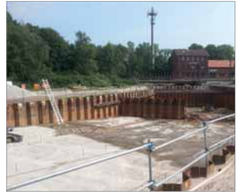
Baustelle Tunnel in Verlängerung Franz-Schütte-Allee
