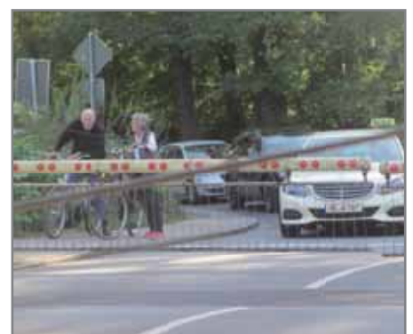
Beschränkter Bahnübergang Rockwinkeler Heerstraße
