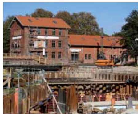
Tunnelbau am Oberneulander Bahnhof
